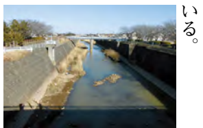
水害発生防止が急がれる八間堀川(常総市)
