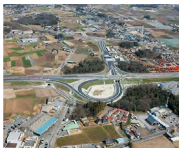
圏央道境古河インターチェンジ(境町)(東日本高速道路(株)提供)
