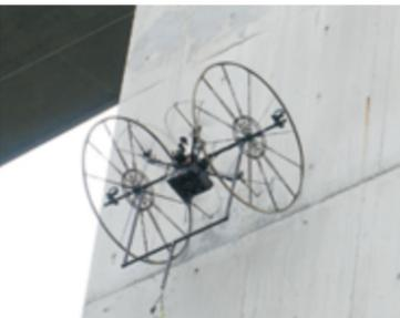
ドローンによる橋りょう点検状況(国立研究開発法人土木研究所提供)
