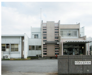
現在の場所で建て替え予定の土浦保健所
