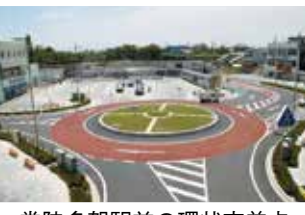
常陸多賀駅前環境交差点(日立市提供)
