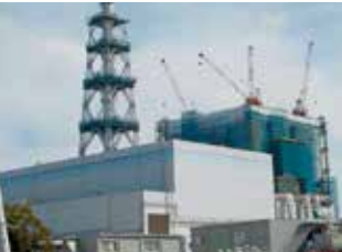
東海第二原子力発電所の外観
