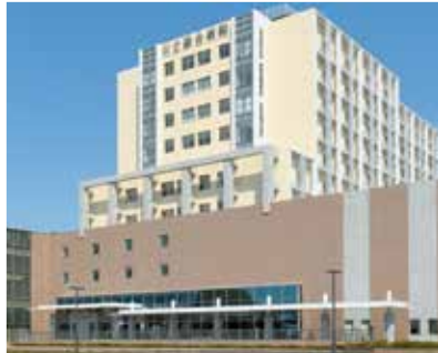
県北地域で中核病院としての役割を担う日立総合病院（日立総合病院提供）
