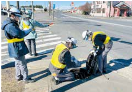
下水道管の緊急点検の様子
