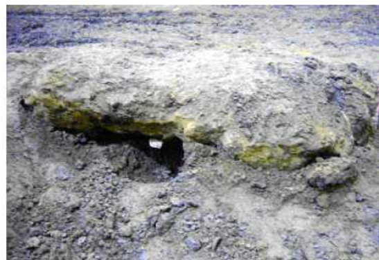
北側で発見されたコンクリート様の塊 （東西1m×南北2m×深さ50cm）
