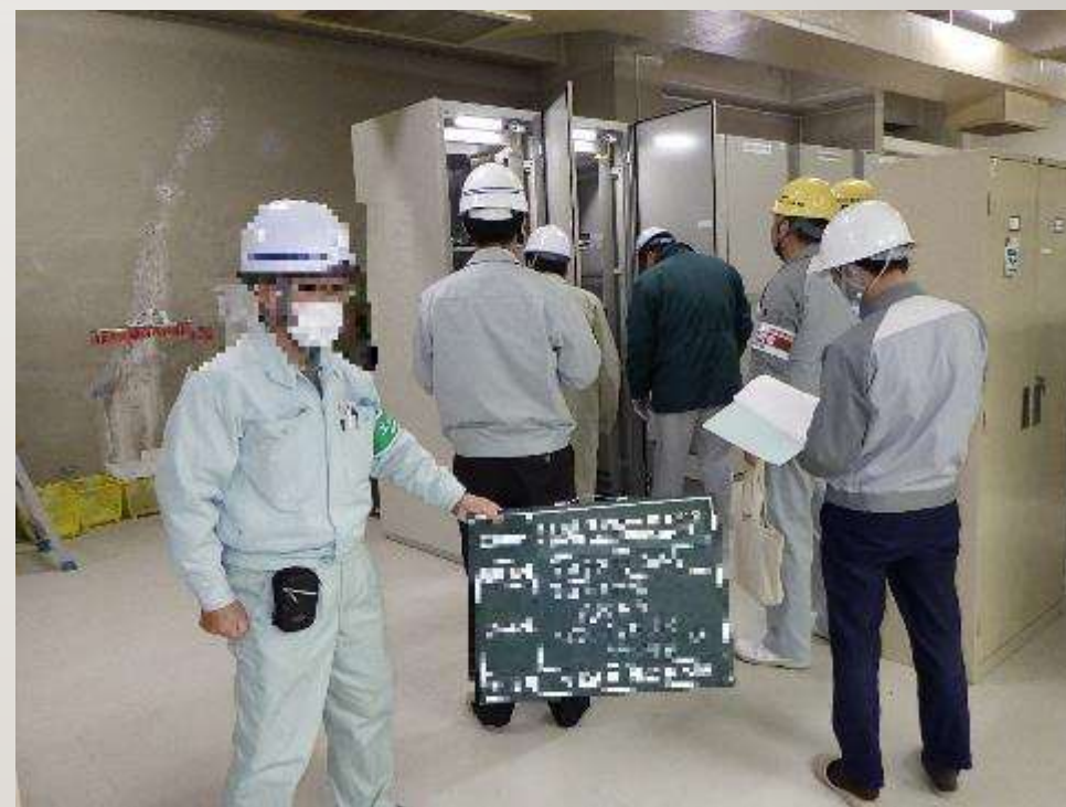
中間検査（現場）
