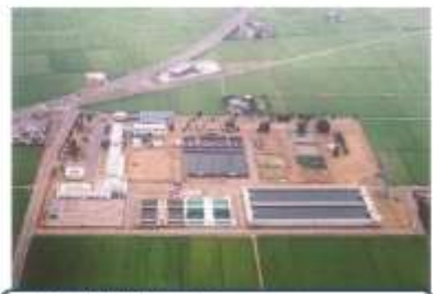
那珂川浄水場(那珂市西木倉)
