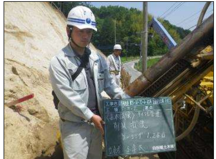
現場監督の状況
