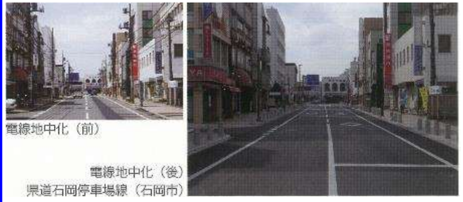
電線類の地中化
