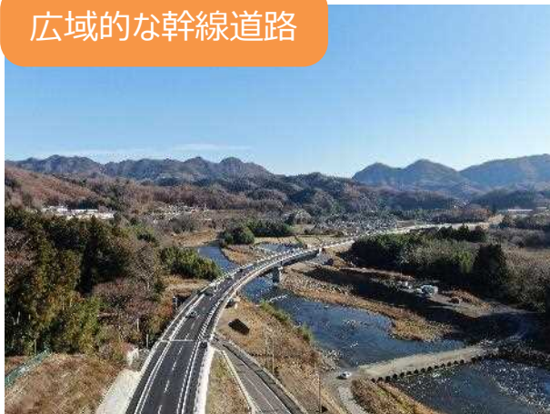
国道118号袋田バイパス
