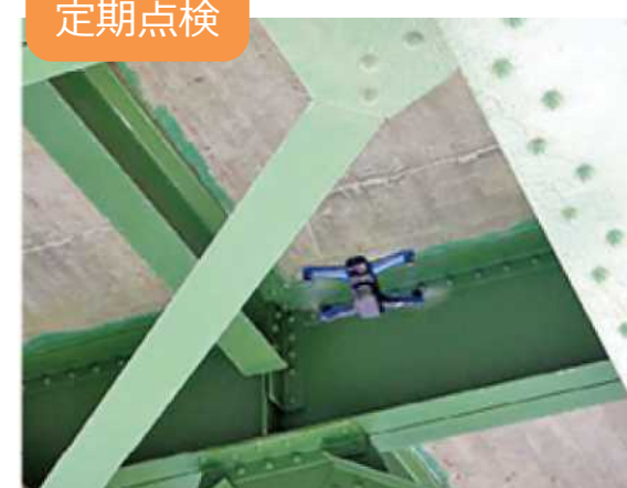
ドローンによる橋梁点検
