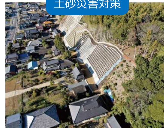
急傾斜地崩壊対策（弁才天2）
