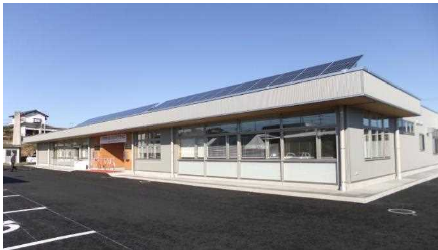
土木事務所（外観）
