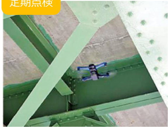
ドローンによる橋梁点検
