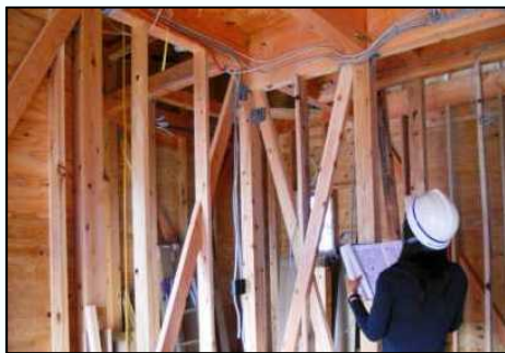
木造建築物の中間検査
