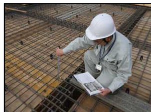
工事監理 (鉄筋の配筋確認)
