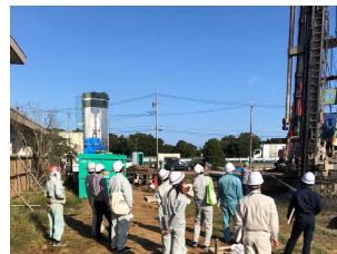
工事監理 (杭打ち立会い)
