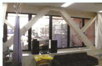
大規模建築物の耐震改修 （ブレース設置）
