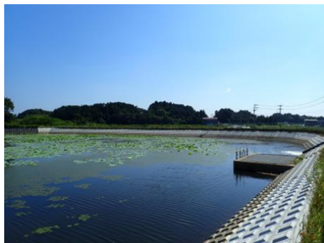
農業用ため池の整備
