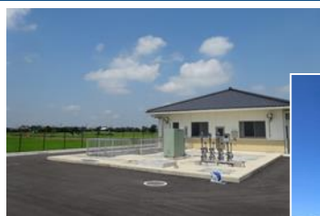
農業集落排水施設
