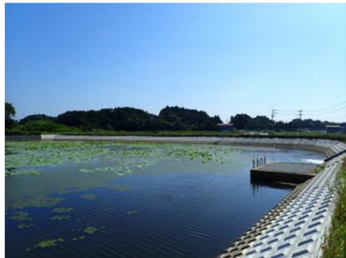
農業用ため池の整備
