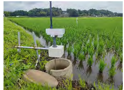
ICT自動給水栓の導入
