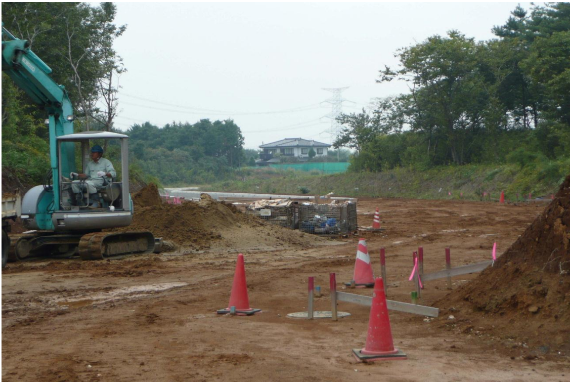
平成 22 年 10 月 12 日現在の道路工事写真(2)
