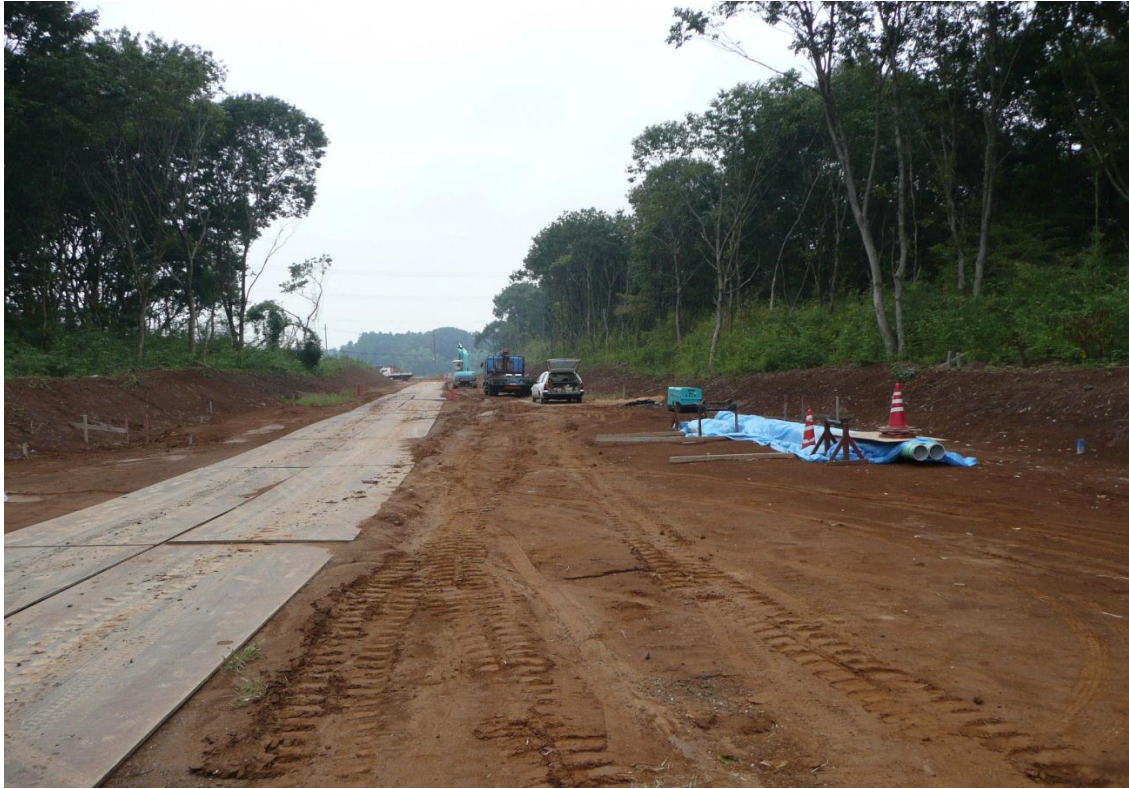
平成 22 年 10 月 12 日現在の道路工事写真(1)
