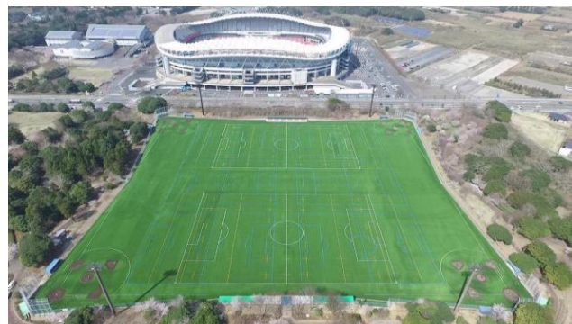
整備予定地（ト伝の郷運動公園）外観
