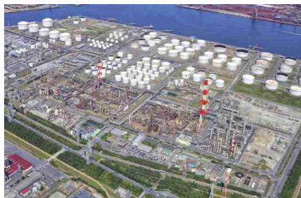
①鹿島石油株式会社 鹿島製油所
