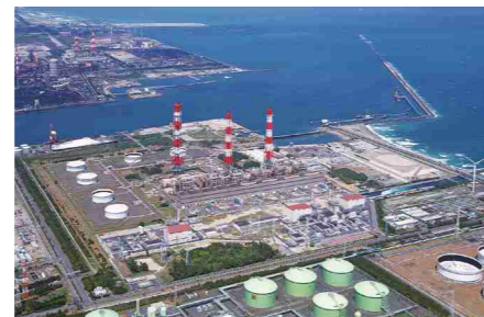
②株式会社JERA 鹿島火力発電所
