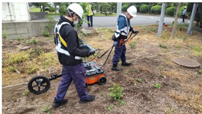
下水道の空洞化調査
