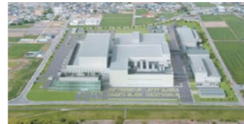
EL APSC 合同会社 下妻工場 (エステローダーグループ)
