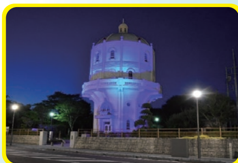
水戸市水道低区配水塔
