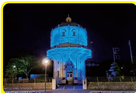
水戸市水道低区配水塔
