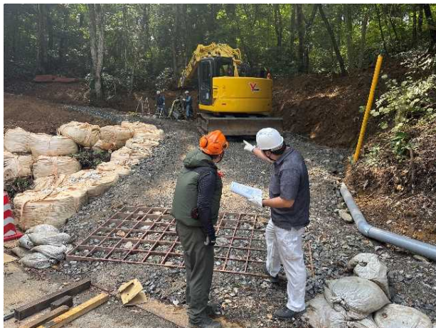
作業道取付部指導（石岡市）
