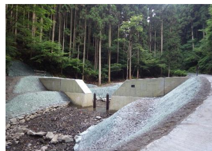
流木捕捉型治山ダム
