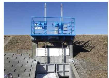
木製からステンレス製に更新したゲート
