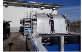
除塵機設備工事（完成）
