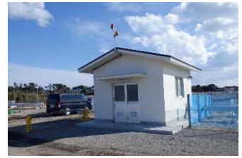
用水機場工事（完成）
