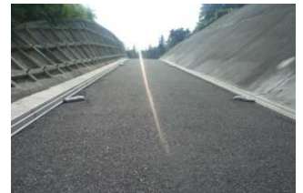
農道舗装工事（完成）
