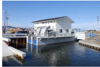
排水機場工事（完成）
