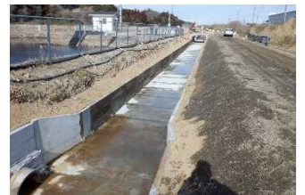
赤浜地区排水路工事(完成)
