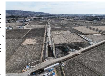
排水路や道路整備が進む小目地区
