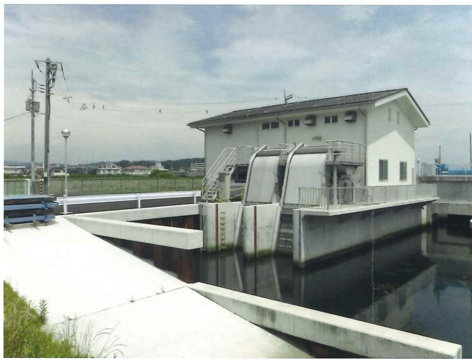
北茨城市 県営かんがい排水事業 下桜井地区 排水機場
