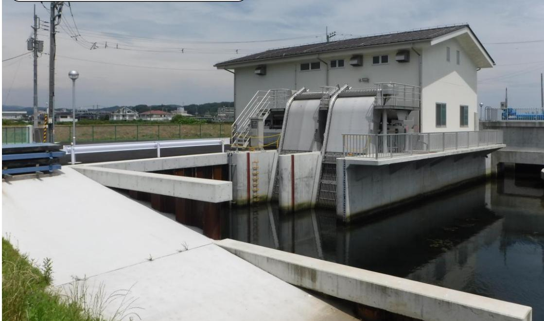
下桜井地区は、大北川の河口部に位置し、洪水時の湛水や地下水位の影響で転作も困難な状況でした。写真は、事業で新設した排水機場で、地区内の排水路と一体的に整備することで、湛水被害が解消され、乾田化による転作作物も導入できる農地になりました。
