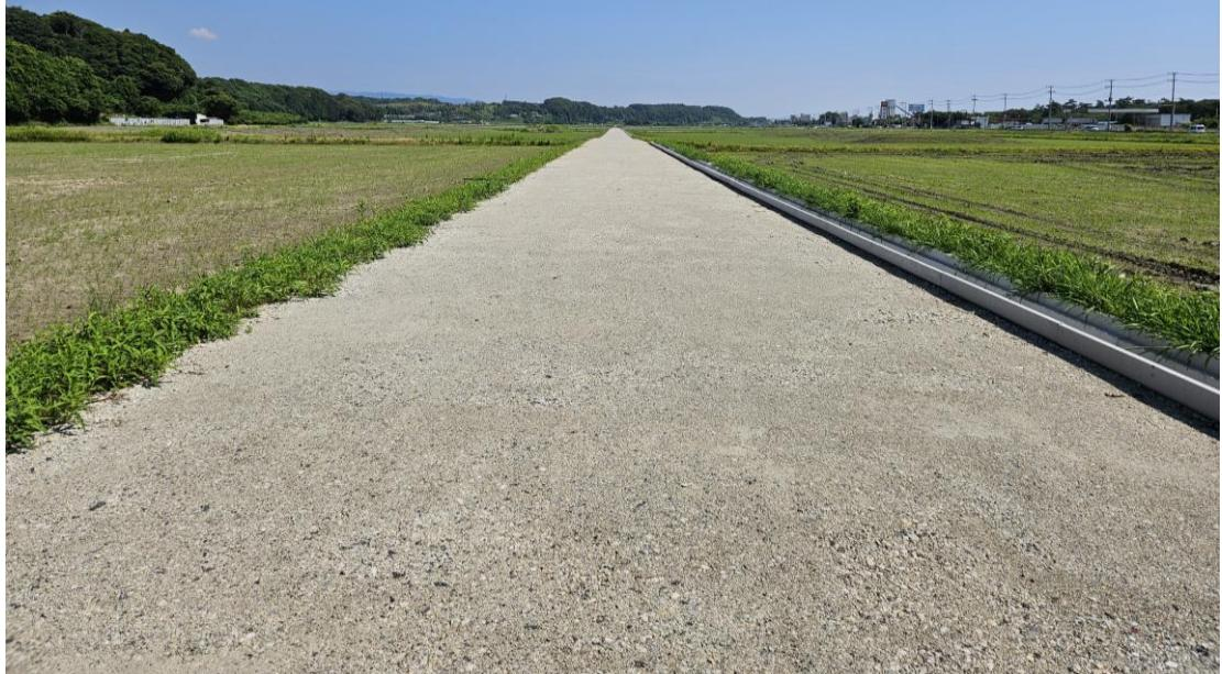
伊師地区では、2022年度（令和4年度）から地域の農作物や生産資材の搬入等の効率化を目的として約1.7kmの道路改良工事を行っています。写真は、路床入替が完了した一部区間になり、最終的には舗装された道路に生まれ変わります。
