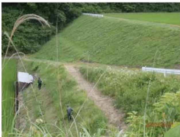
法面除草作業
