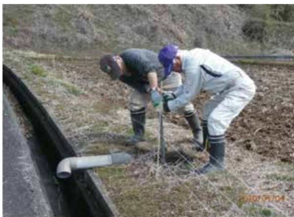
配管の空気抜き
