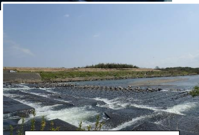
4月8日 久慈川堅磐堰の様子
