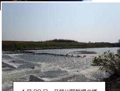
4月30日 久慈川堅磐堰の様子
