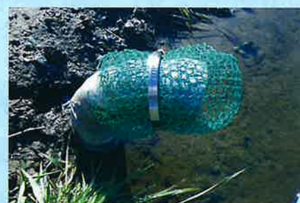
図5 取水口へのネット設置例
