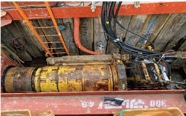
管水路整備(早井東部地区:施工状況)
