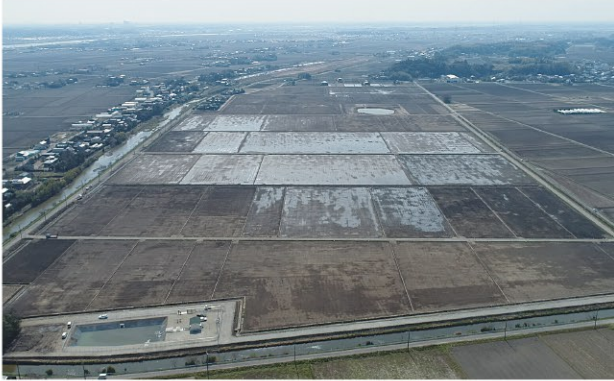
大区画化ほ場(利根北部地区:工事施工後)
