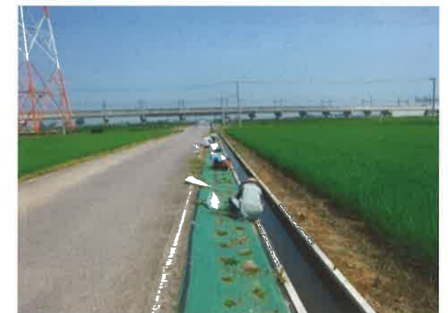
植栽地への防草シート設置・除草作業
