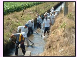
水路の泥上げ
