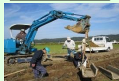
コンクリート水路の更新
