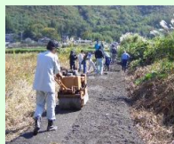
未舗装農道の舗装
