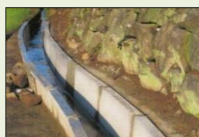
素堀り水路からの更新
