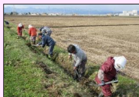
水路の泥上げ
