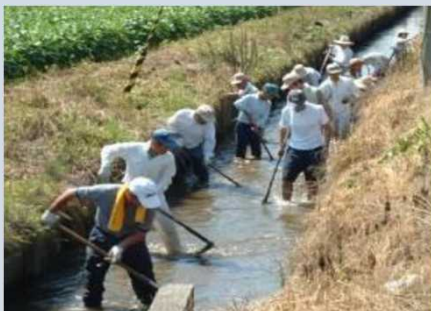
水路の泥上げ
