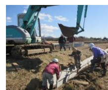
コンクリート水路の布設
