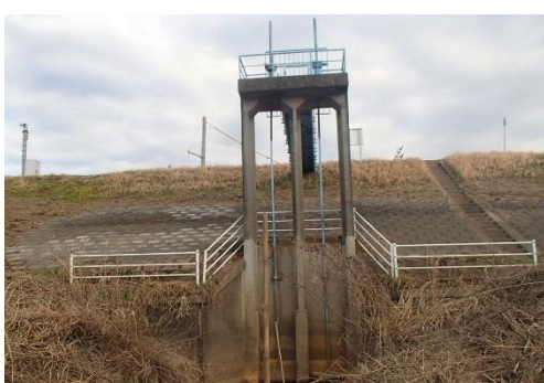
新堀揚水機場地区（下妻市）H28～R1
