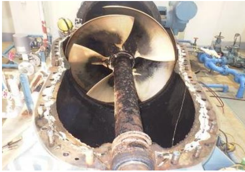
本新排水機場地区（稲敷市）H27～R3
