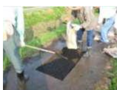
農道の部分補修
