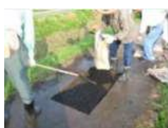
農道の部分補修
