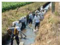
水路の泥上げ
