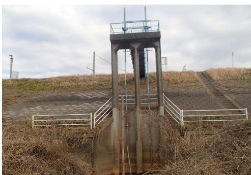
新堀揚水機場地区（下妻市）H28～R1
