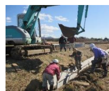
コンクリート水路の布設
