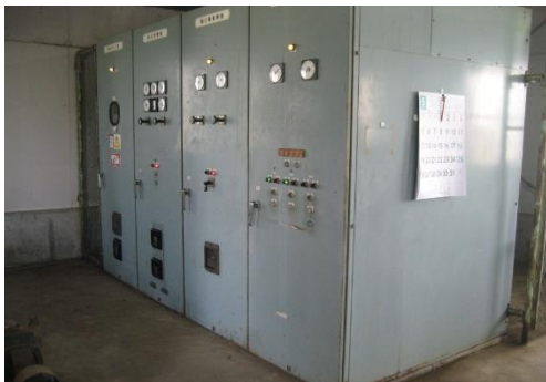
河内第6 機場地区（河内町）H25～H30
