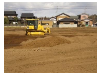
区画整理工事施工状況
