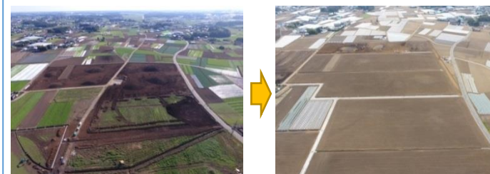
尾崎北部地区(左:施工前,右:施工後)
