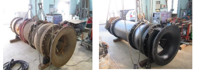
改修前後のポンプ状況(左:改修前, 右:改修後)
