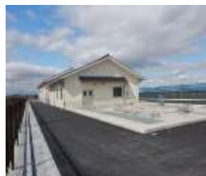
新たに整備された処理施設
