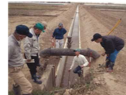
排水対策のための施設整備
