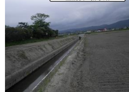
整備後の排水路
