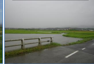
大雨時の湛水状況
