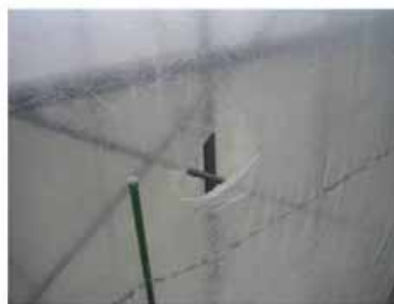
図 -2-3 二重被覆の破れ
