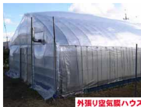
図-2-12 空気膜ハウスの断面図および外観
