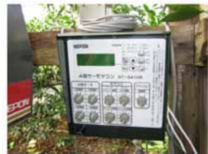
図 -2-7 多段式サーモ装置 注) 価格は4～5万円、暖房機付属の温度センサーをはずし、接続する
