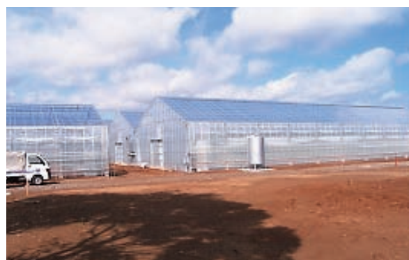
整備が進む栽培施設と建設予定地
