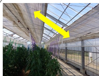
日射量により遮光カーテンを自動で開閉
