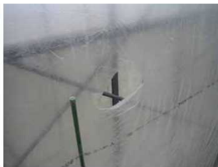
図II-2-3 2重被覆の破れ
