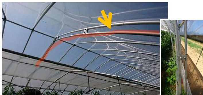
図-36 ダブルアーチパイプで強化
