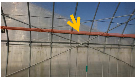
図－２９ 足場用直管パイプによる側面補強
