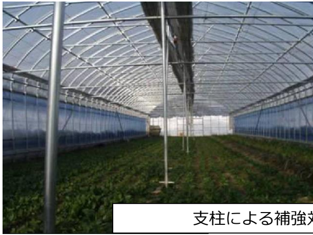
図ー４１ ハウスの雪害対策（福井県雪害対策マニュアル）
