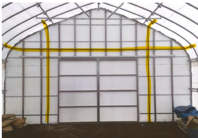
図- 2 4 妻面の補強対策（L字パイプによる補強）
