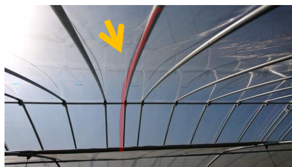
図-37 アーチパイプ増設による強化
