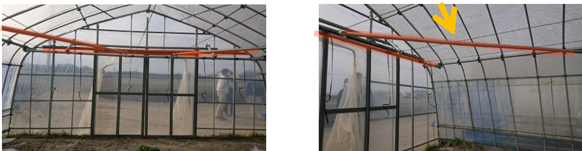
図－２８ 足場用直管パイプによる妻面補強
