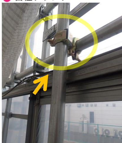
図- 2 5 レール式ドアの補強パイプの取付
