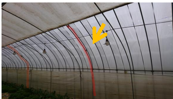
図-3-3 ダブルアーチパイプによる強化
