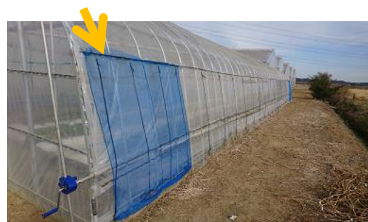
図－３０ 防風ネットによる被覆資材の破損防止
