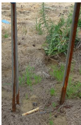
写真2 脚部の腐食
