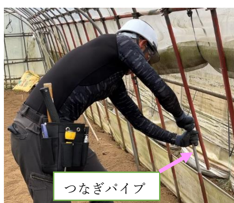
写真6 パイプかしめ器で締める
