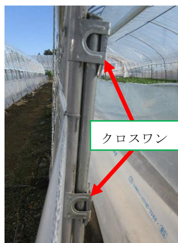
写真2 呼びつぎ法による補強
