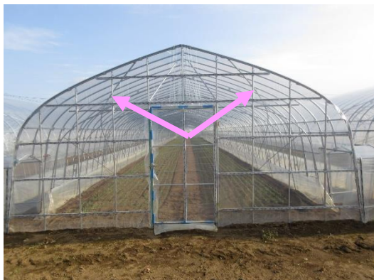
写真3 筋交いの設置間隔 (0~3m)
