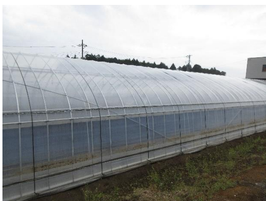
写真1 筋交いの設置状況
