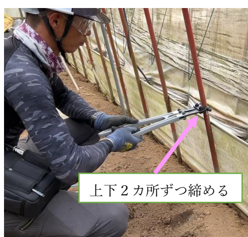
写真6 パイプかしめ器で締める
