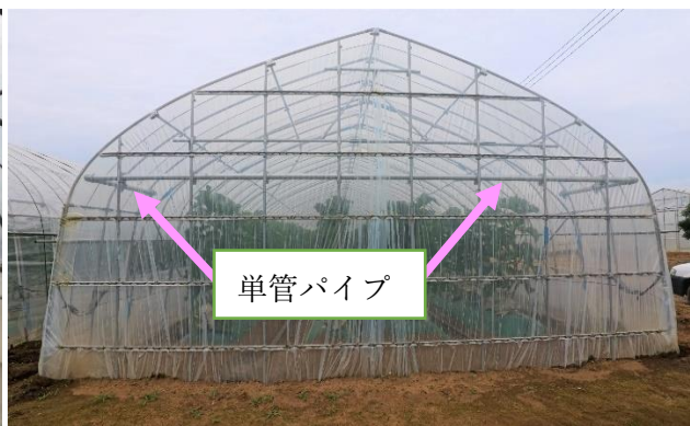
写真2 妻面（扉の反対側）
