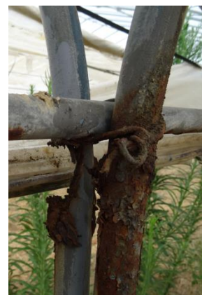
写真3 肩部の腐食
