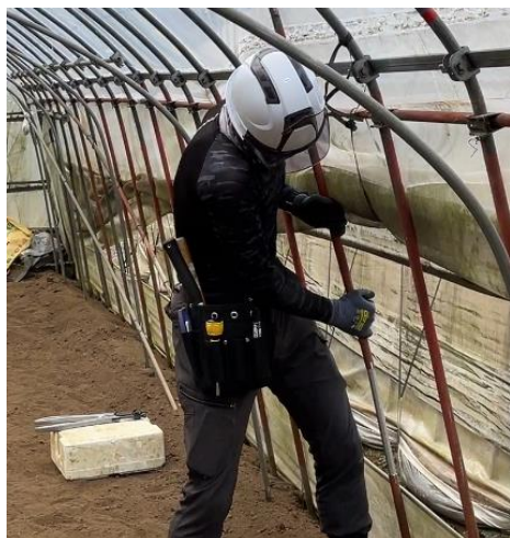
写真5 アーチパイプを上から被せる
