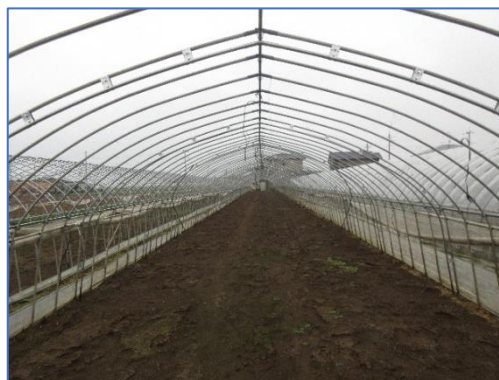
写真2 ダブルアーチ設置状況
