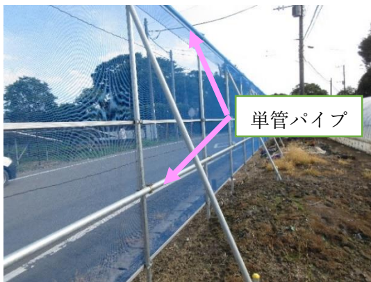
写真5 上部・中部下の横2列の単管パイプ
