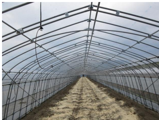
写真2 ダブルアーチの設置状況
