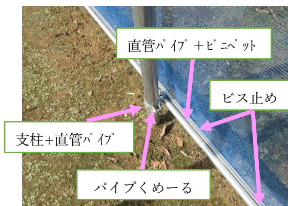
写真4 支柱と直管パイプ、直管パイプとビニネットの接合
