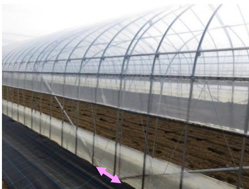
写真3 筋交いの設置間隔 (0~3m)
