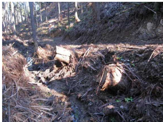
写真-5 盛土法面保護
