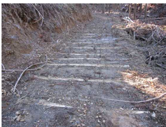
写真-3 丸太路面処理
