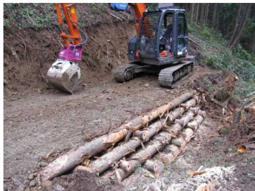
写真-1 丸太組工
