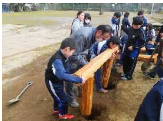
写真-4 ベンチの設置作業
