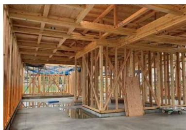
木造店舗の施工状況
